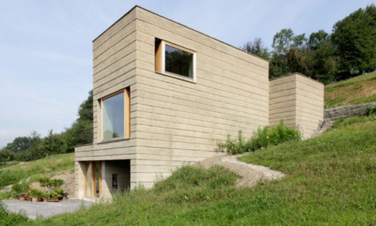
Photos : Maison Rauch, Martin Rauch et Roger Boltshauser © Beat Bühler
